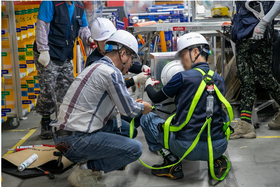
工程安全團隊的Kane正在檢查HVAC項目施工現場的安全管理現況。
