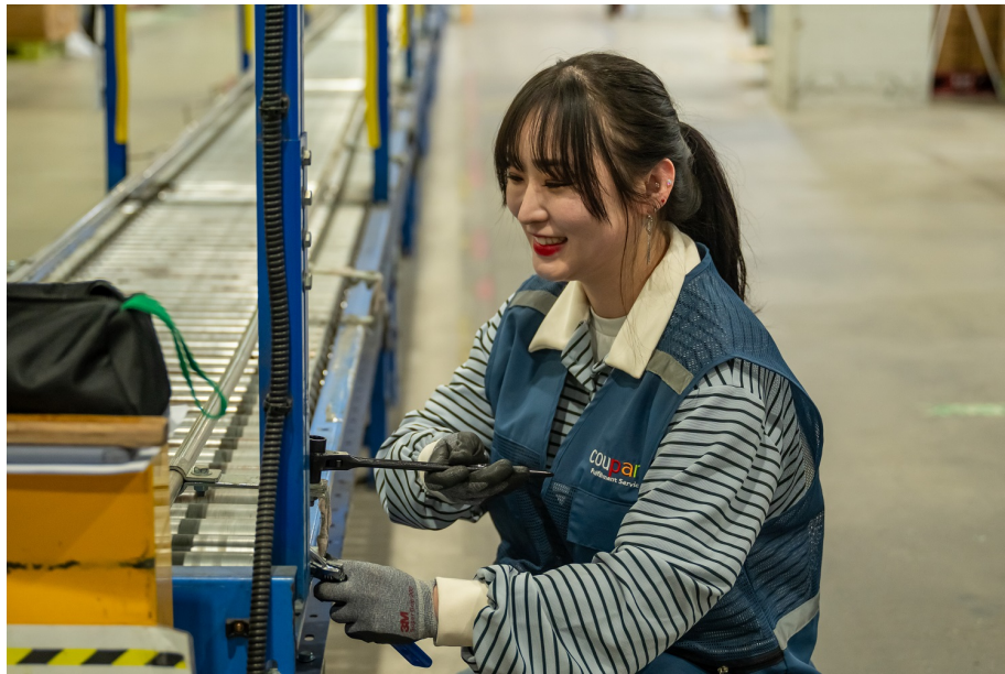
Coupang酷澎物流服務自動化團隊的Park-Sojin正在固定FC內滾筒輸送機的導桿支架。
